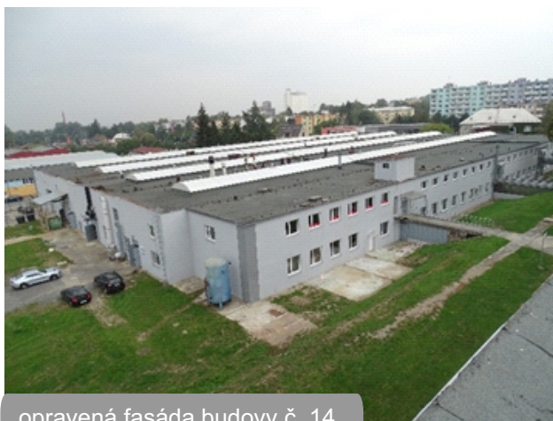
opravená fasáda budovy č. 14
